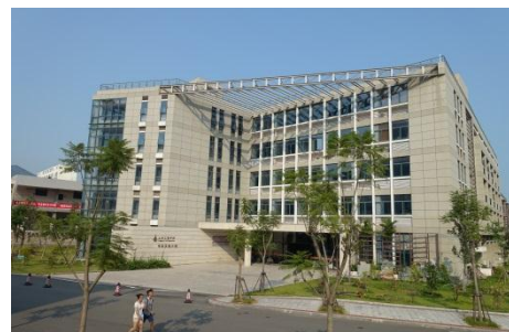
土木工程学科实验大楼外观
